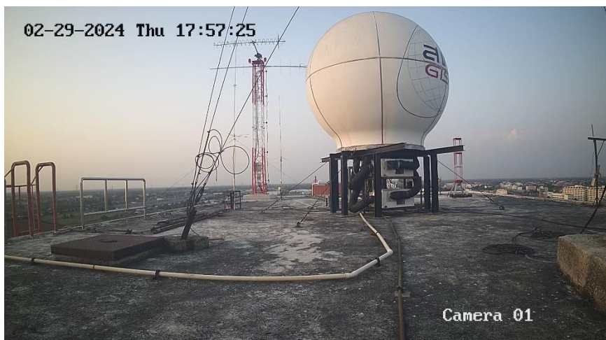
ภาพที่ 4 ตัวอย่างสถานีภาคพื้นดินสำหรับติดตามดาวเทียมขนาดใหญ่ ที่มหาวิทยาลัยมหานคร กรุงเทพฯ
